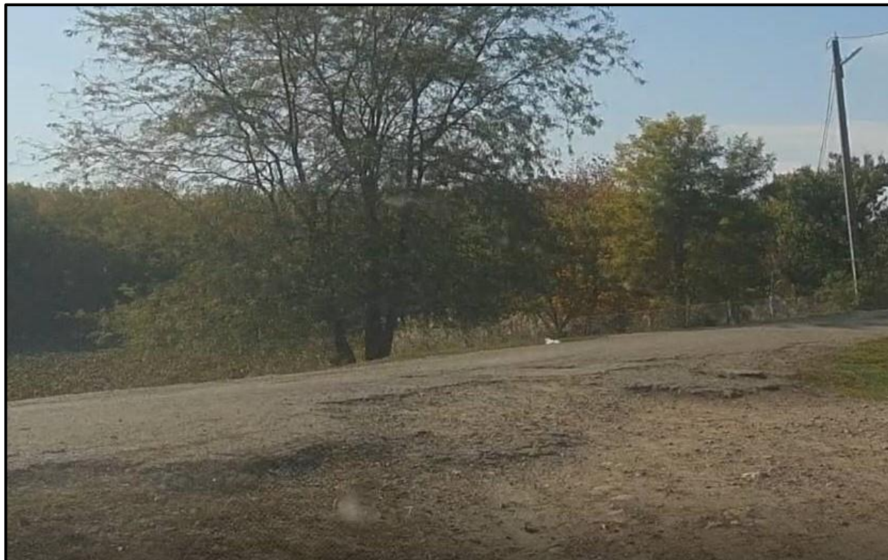
Фото 1.3.3 – Фрагмент дорожной одежды на ул. Калинина
