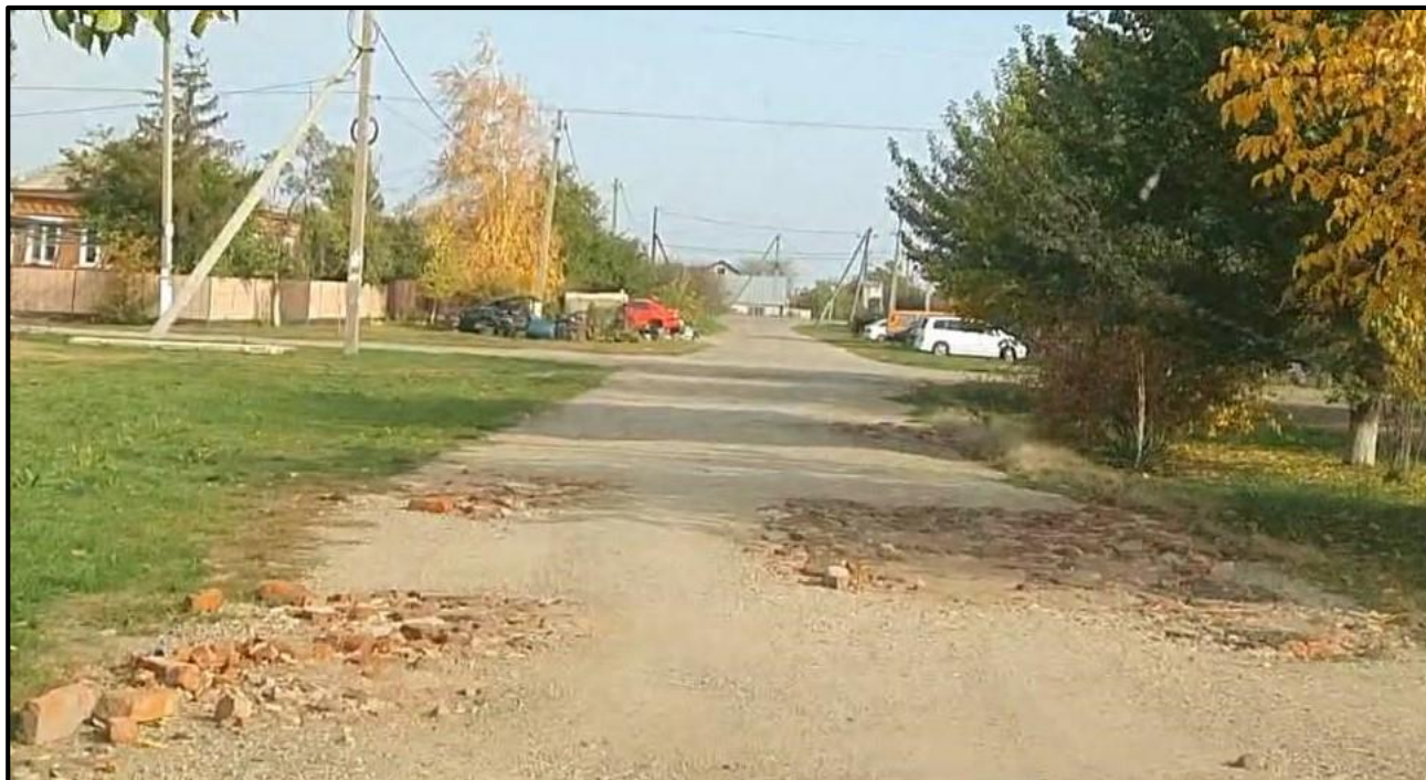
Фото 1.3.5 – Фрагмент дорожной одежды на ул. Комсомольская
