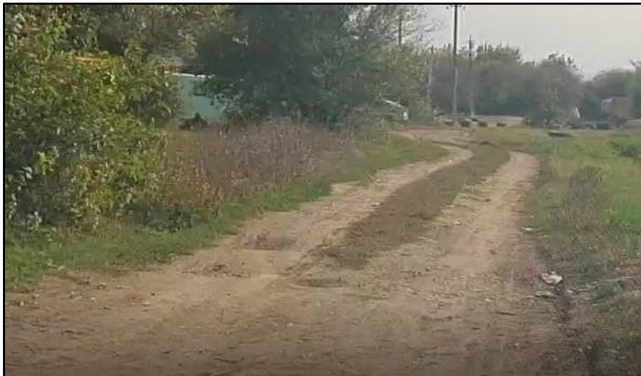
Фото 1.3.7 – Фрагмент грунтовой дороги ул. Южная
