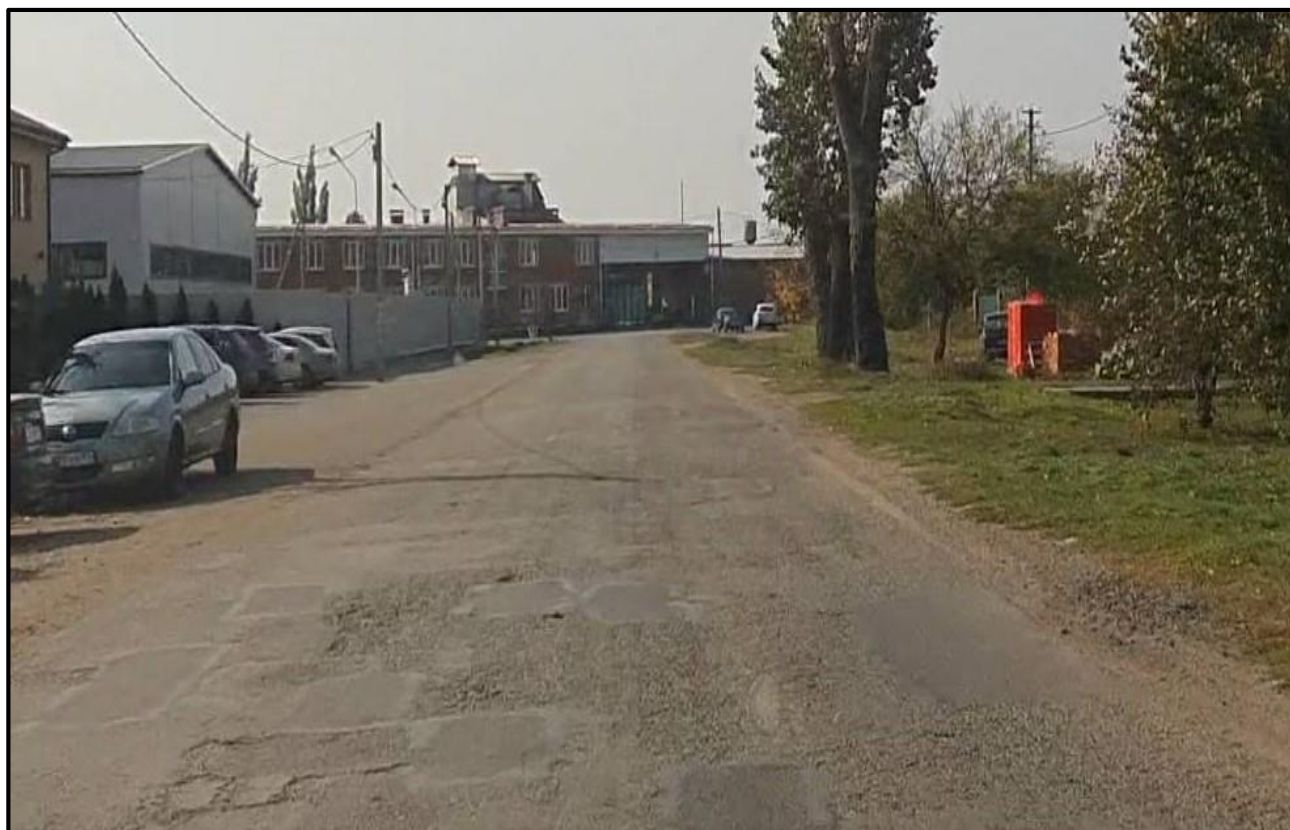
Фото 1.3.4 – Фрагмент дорожной одежды на ул. Калинина
