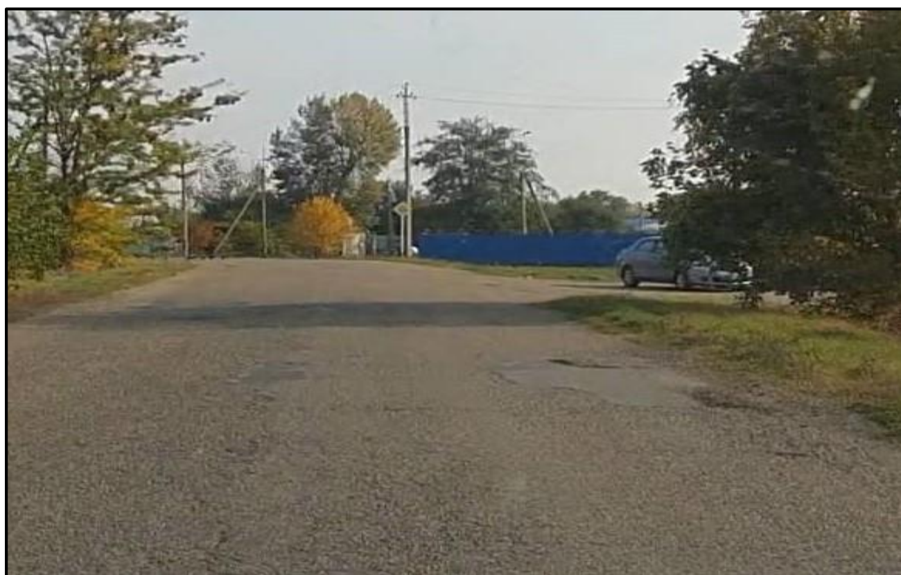
Фото 1.3.2 – Фрагмент дорожной одежды на ул. Кучерявого
