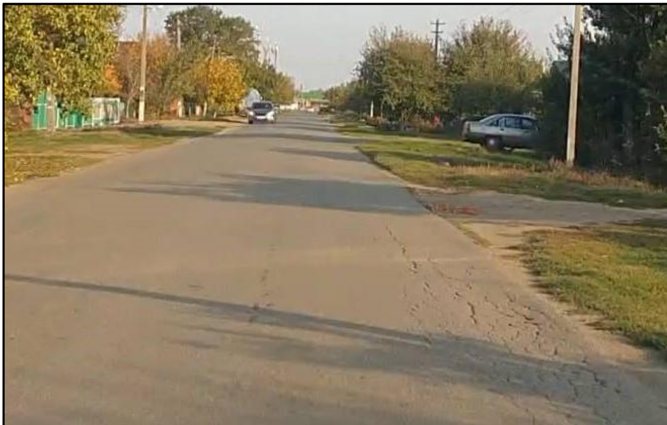
Фото 1.3.1 – Фрагмент дорожной одежды на ул. Ленина
