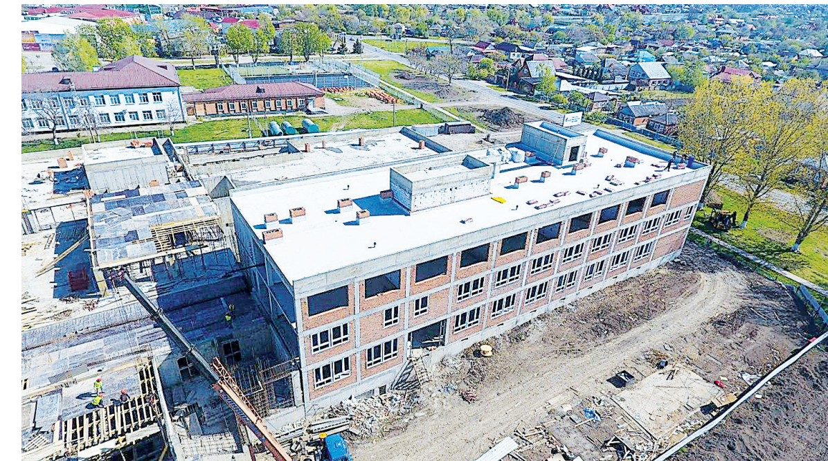
Строительство школы. ФОТО: из открытых источников.
